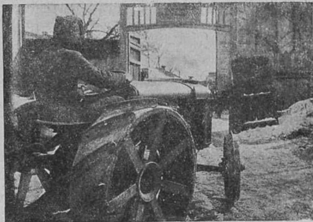
Начинаются зимние работы
