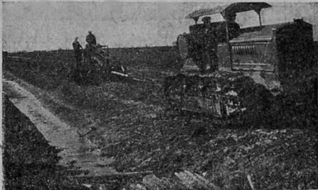
Гусеничный трактор „Коммунар“ в 50 л. с. с грейдером на дорожных работах в совхозе „Колпино“
